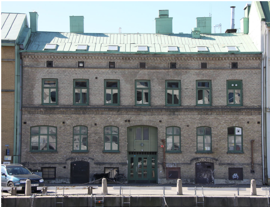
Brogatan 2 restaureras och bevaras efter sitt ursprungliga utseende mot kanalen. (Röda bryggan_Gestaltningssprogram_180412_Högupplöst, 2018)
