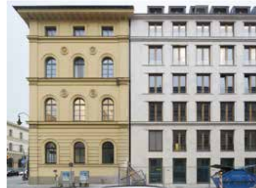
Linjer i befintlig byggnad tas upp i nybyggnad.
